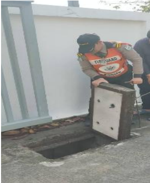
การทำความสะอาดตะแกรงดักมูลฝอย
