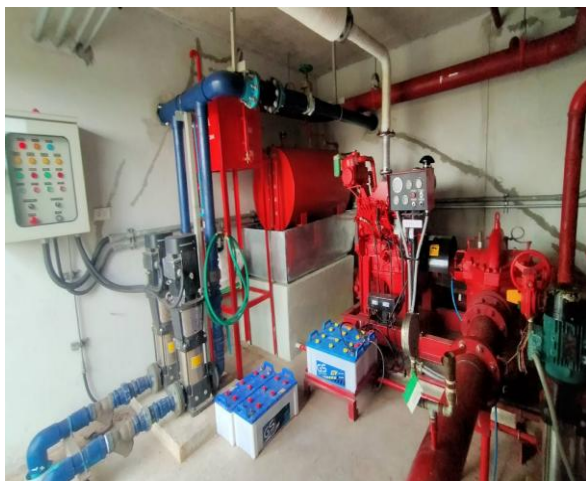
รูปที่ 4 ปั้มน้ำดับเพลิง
