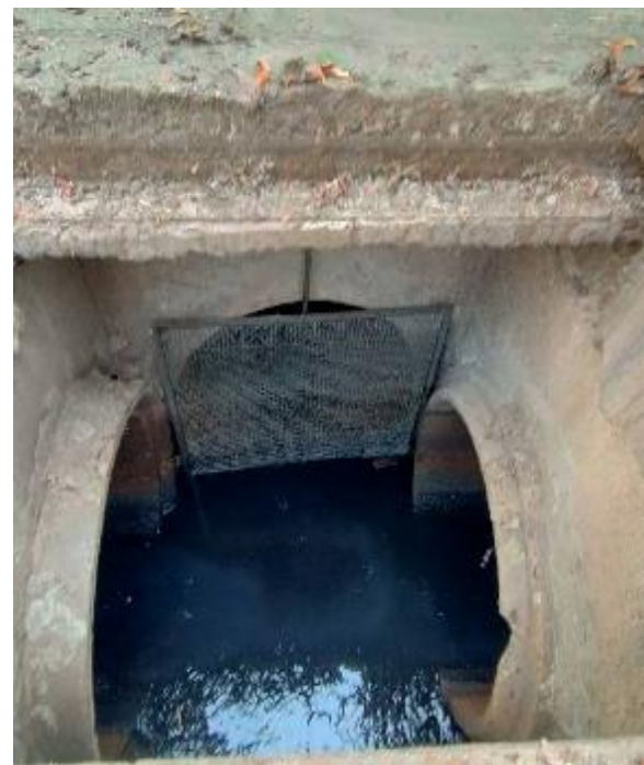
การทำความสะอาดตะแกรงดักมูลฝอย
