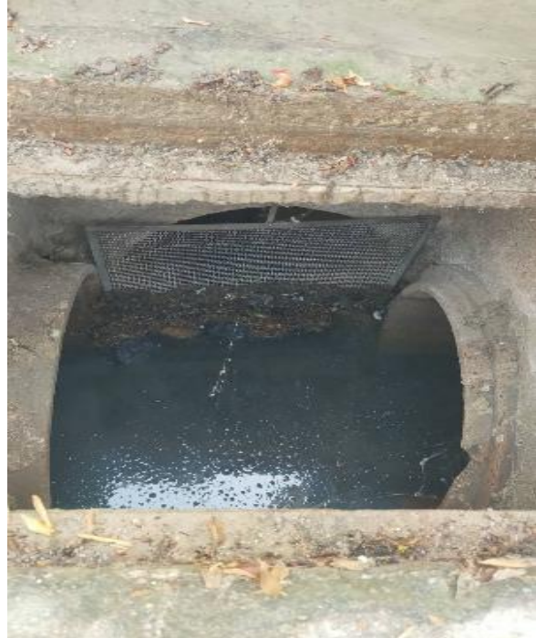
การทำความสะอาดตะแกรงดักมูลฝอย
