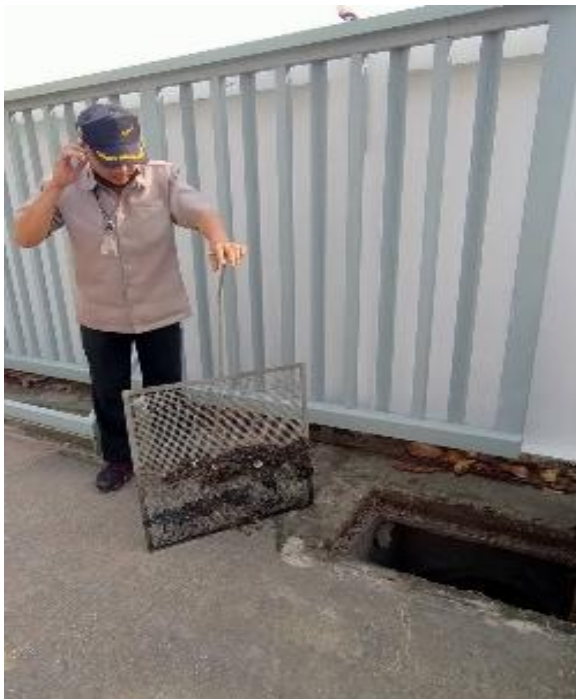
การทำความสะอาดตะแกรงดักมูลฝอย
