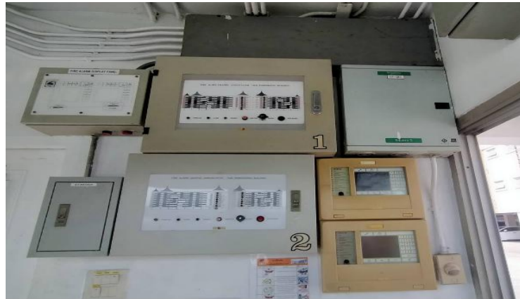
รูปที่ 1 ตู้ควบคุมระบบตรวจจับและแจ้งเหตุเพลิงไหม้
