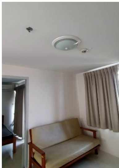
รูปที่ 3 ระบบสปริงเกอร์ และอุปกรณ์ตรวจจับเพลิงไหม้
