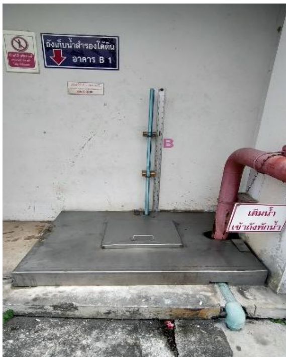
รูปที่ 2 ถังเก็บน้ำสำรองใต้ดิน อาคาร B
