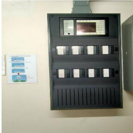
รูปที่ 1 ตู้ควบคุมระบบตรวจจับและแจ้งเหตุเพลิงไหม้
