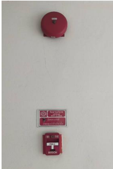
รูปที่ 2 สัญญาณแจ้งเหตุเพลิงไหม้
